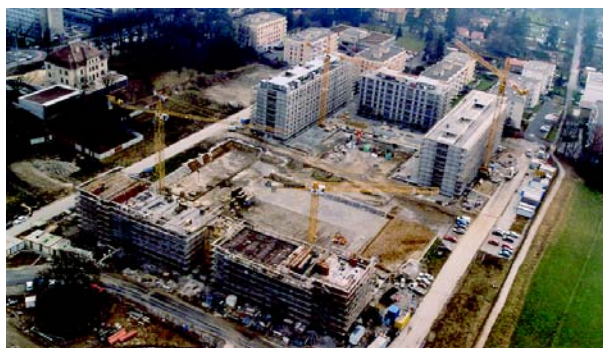
Fig. 7 : Chantier étapes B1 et B2.
